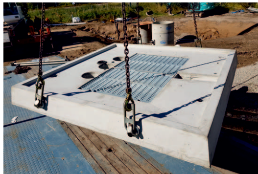
Lyft av bjälklag.
