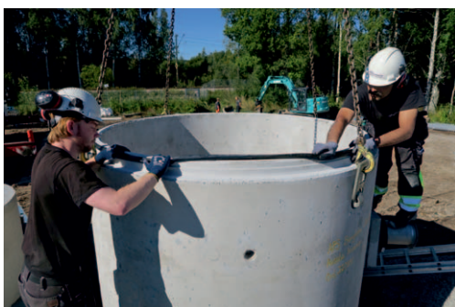
Montera glidfogstättningen över spetsen. Se till att den hamnar i rätt läge.
