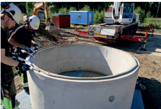
Montering av fogtätning av typ EGOPOL eller likvärdigt.
