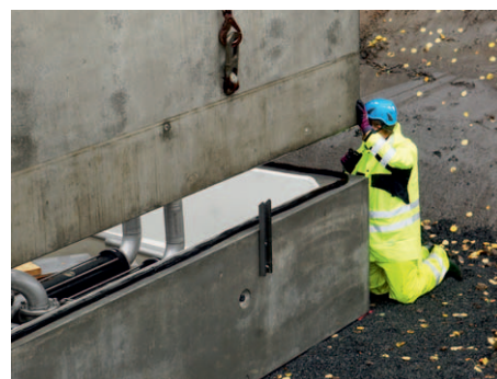
Kolla att fogtätningen inte rubbas. Styr in och sätt ner modulen försiktigt. Styrningarna är mer för att ange riktningen.
