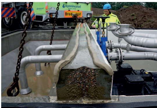
Montera fogtätning på modulbotten- delens mellanvägg.
