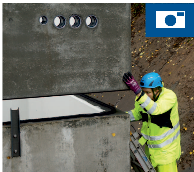
Styr in och sätt ner modulen försiktigt. Styrningarna är mer för att ange riktningen. Kolla att fogtätningen inte rubbas.
