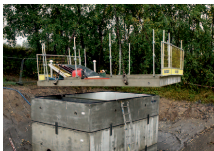
Däcket lyfts på, här med räcke.
