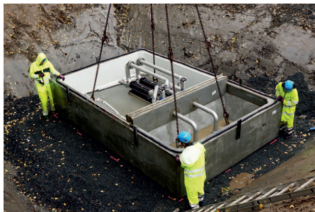
2. Modulbottendelen styrs på plats.
