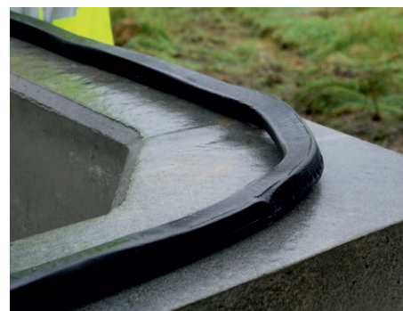
Placering av fogtätningen på modulväggen
