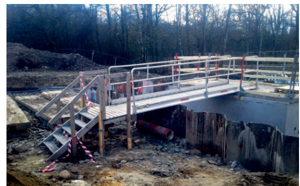
Exempel på landgång visas i bilden. Se även sid 15 gällande skyddsräcke
