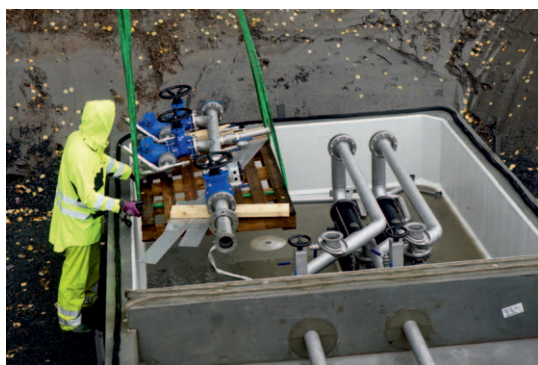
Planera att moduler, rörinredning och mellanväggar monteras i rätt ordning.
