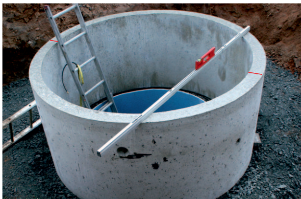
4. Lämpligt avvägningsinstrument används som t.ex. laser och/eller vattenpass
